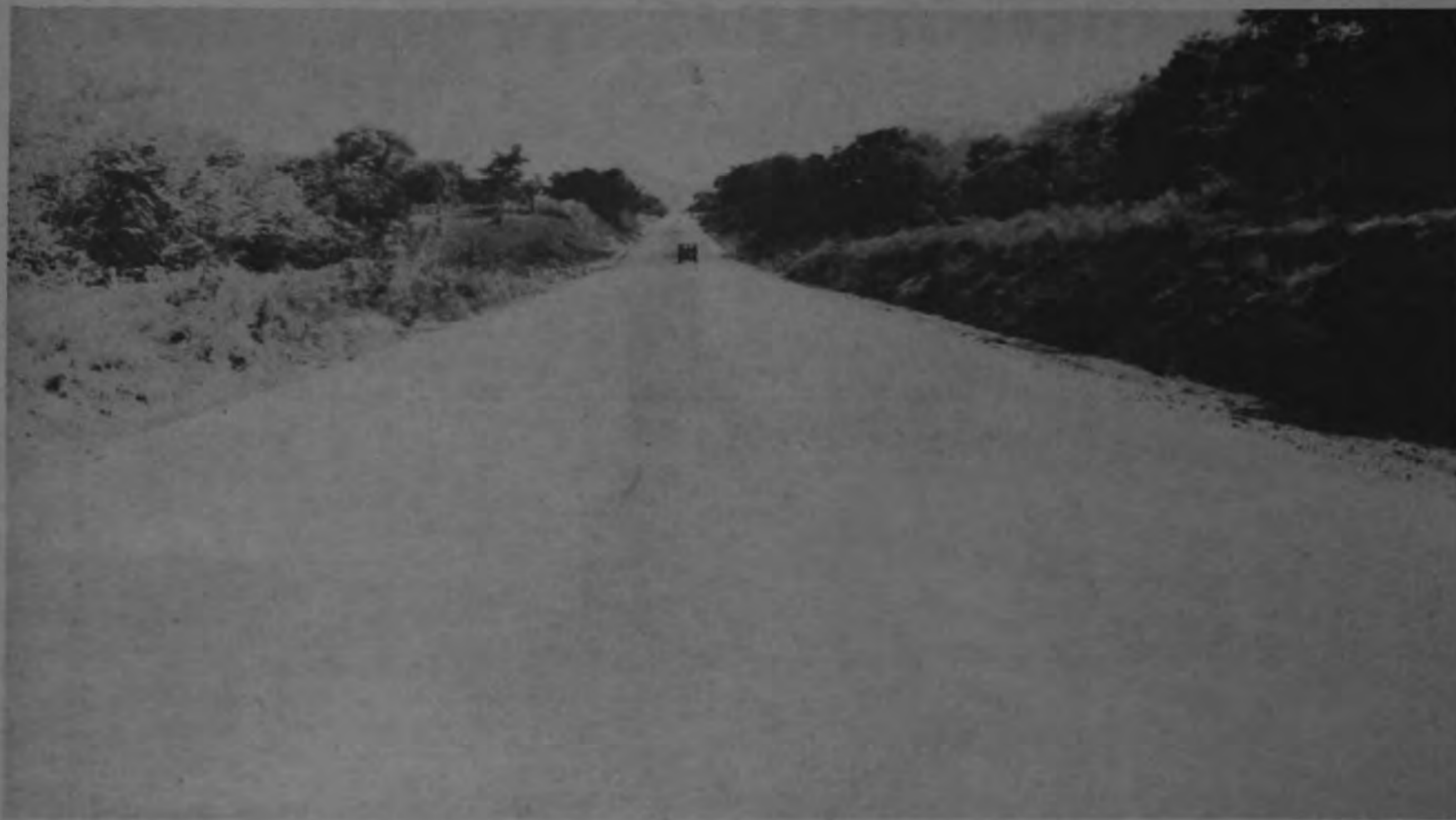
Un aspecto de la carretera entre Nicoya y Colonia Carmona, la cual se encuentra totalmente concluida. La via cuenta con una longitud de 33,7 kilómetros y un costo aproximado a los 32 millones de colones. Esta nueva ruta acortará grandemente las distancias entre estas dos regiones al tiempo que habilitará regiones de gran potencial agropecuario.
