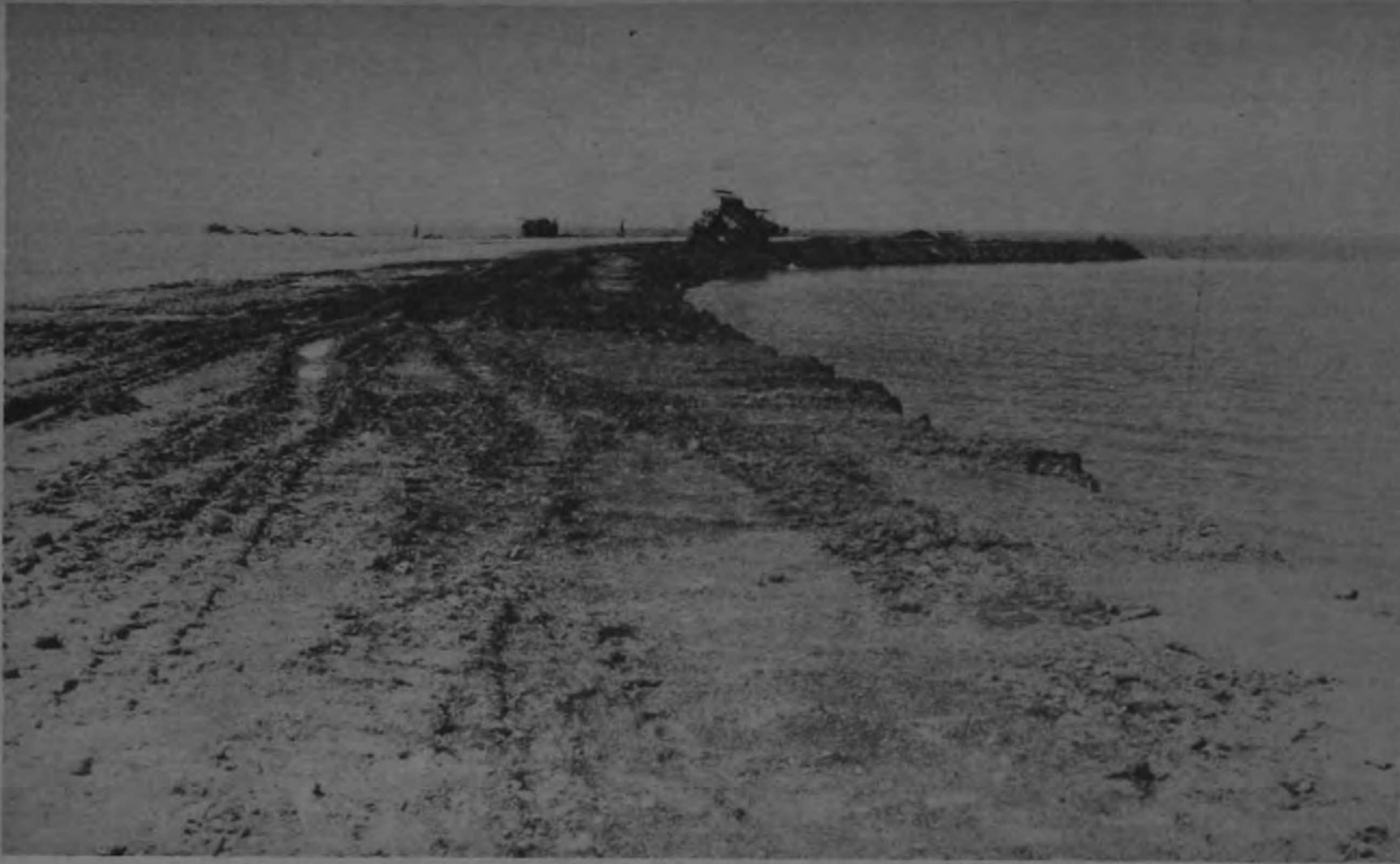
Un aspecto de los trabajos que se llevan a cabo en el Nuevo Puerto de Caldera. Actualmente se trabaja en forma paralela en la recuperación de terrenos, así como en la construcción del tajamar exterior.
