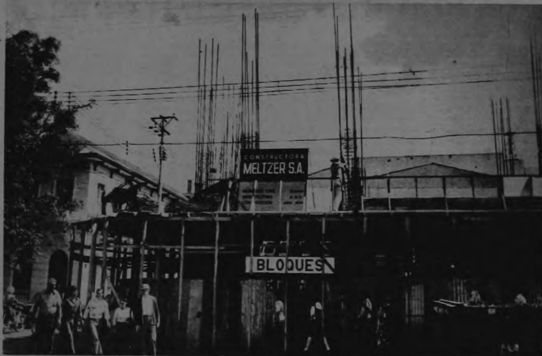
En la esquina del Banco Central se construye un nuevo edificio.
